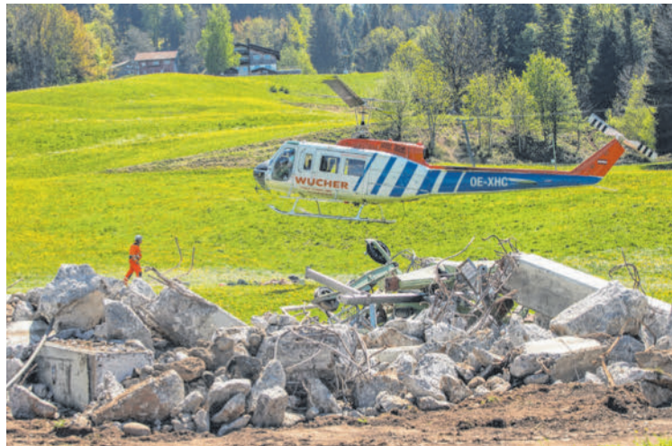
Bereit für das Recycling: Am Montag wurden die Teile von schwer zugänglichen Stützen per Hubschrauber ins Tal geflogen. VN/STEURER
